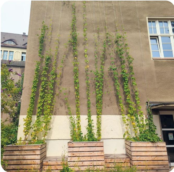
Abbildung 4: FaBiKli Fassadenbegrünung an einer Schule in Berlin mit Bewässerungssystem mit Solarzellen-betriebener Pumpe. Die Pumpe befüllt die Grundwasserspiegel und überwindet den Türbogen auf der rechten Seite. (© Y. Dahm).
